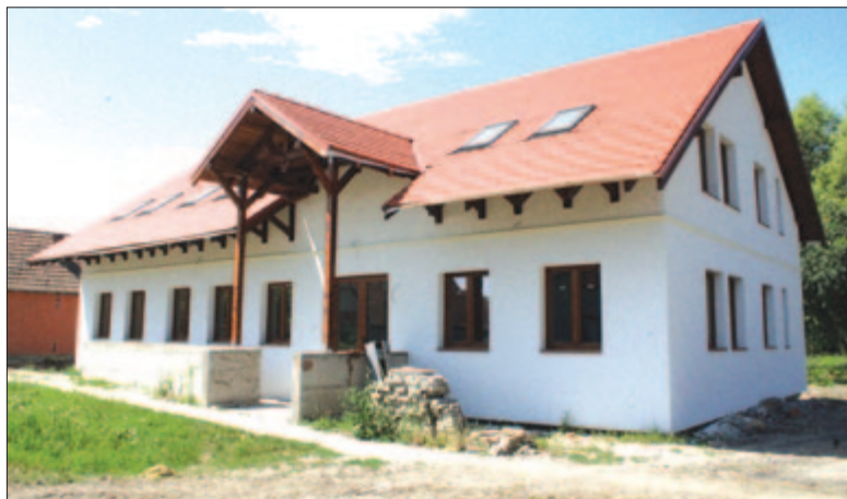
A káposztásszentmiklósi szolgálati lakások épülete
