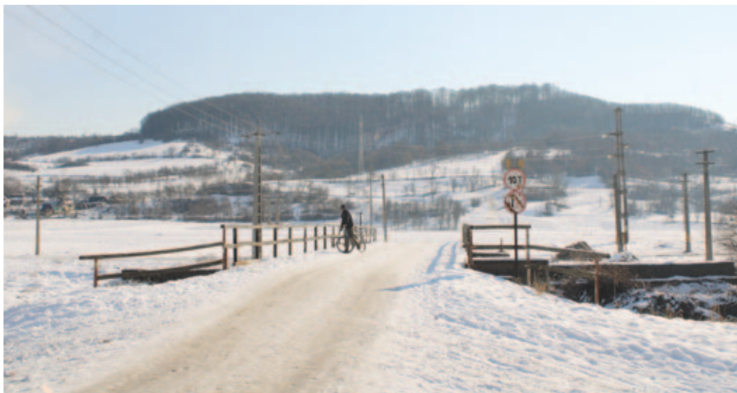
A felújítás előtt álló híd
