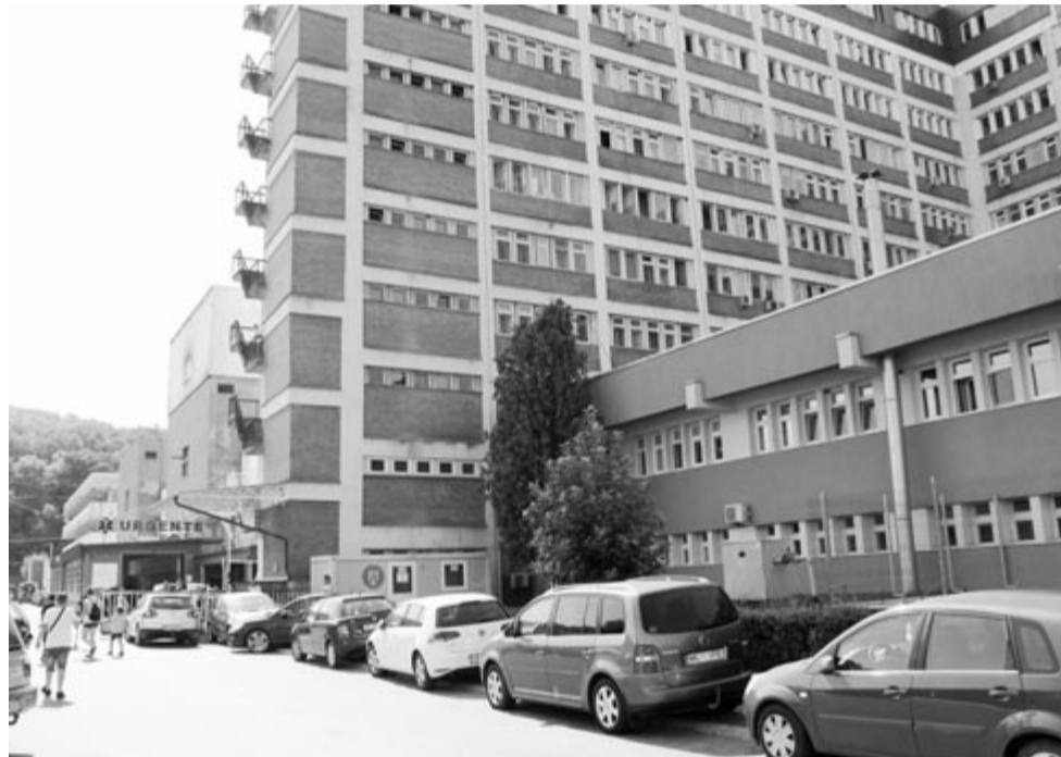
A sürgősségi kórház hátsó bejáratánál bővíték az épületet
