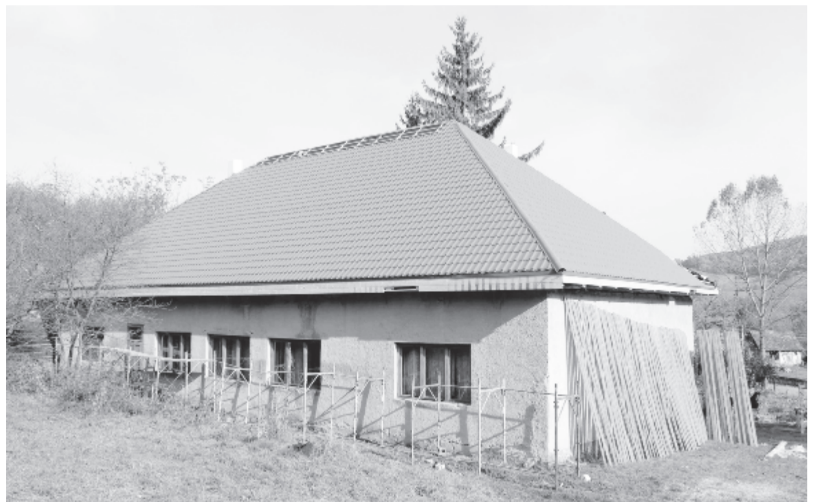
A kultúrothon tetőzete mindenhol beázott – nemrég elkezdődött az épület teljes felújítása
